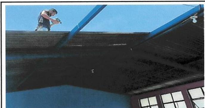
Foto 3: instalación de lámina troquelada
