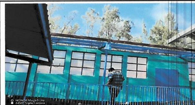
Foto 4: mantenimiento y retoque de pintura a la estructura de soporte de techo metal.
