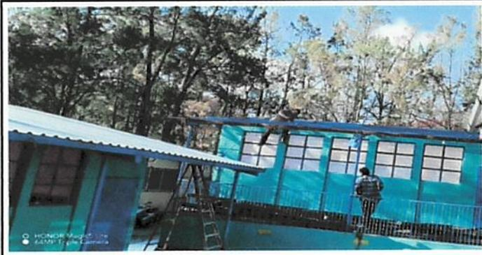
Foto 1: instalación de lámina troquelada en techo de Aula No. 4 y corredor.
